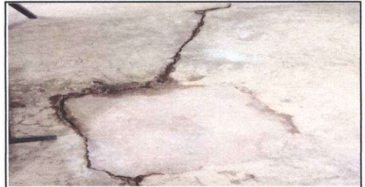
Foto 6: Se observa el piso en mal estado se necesita sustituir
