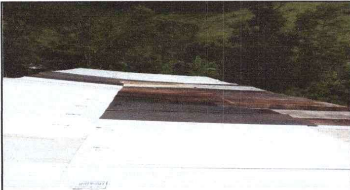
Foto 3: Se observa las láminas del establecimiento en mal estado se necesita sustituir.
