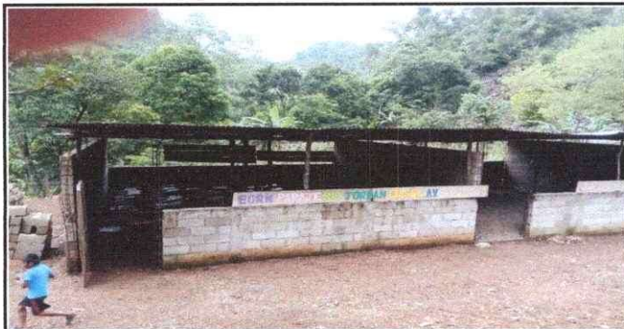
Foto 5: Se observa las ventanas caídas necesita sustituir
